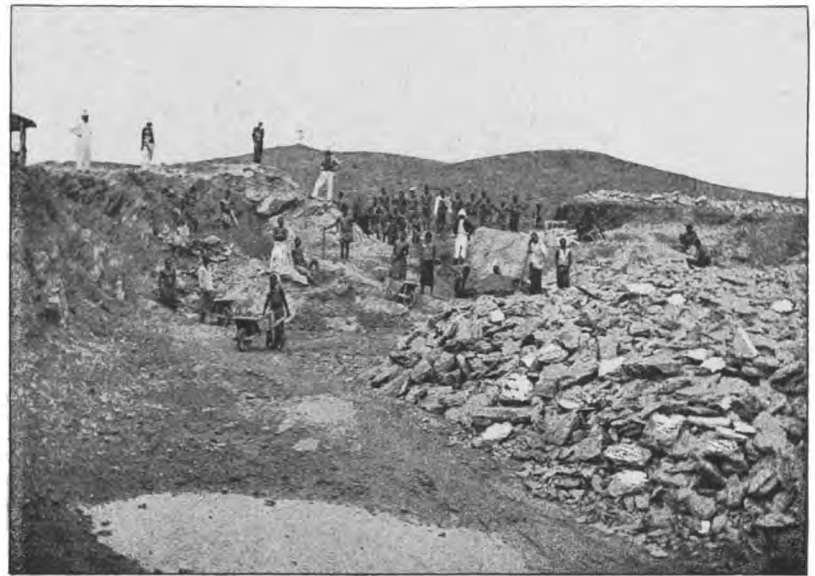
TRAVAUX DU FORT DE SHINKAKASA.
